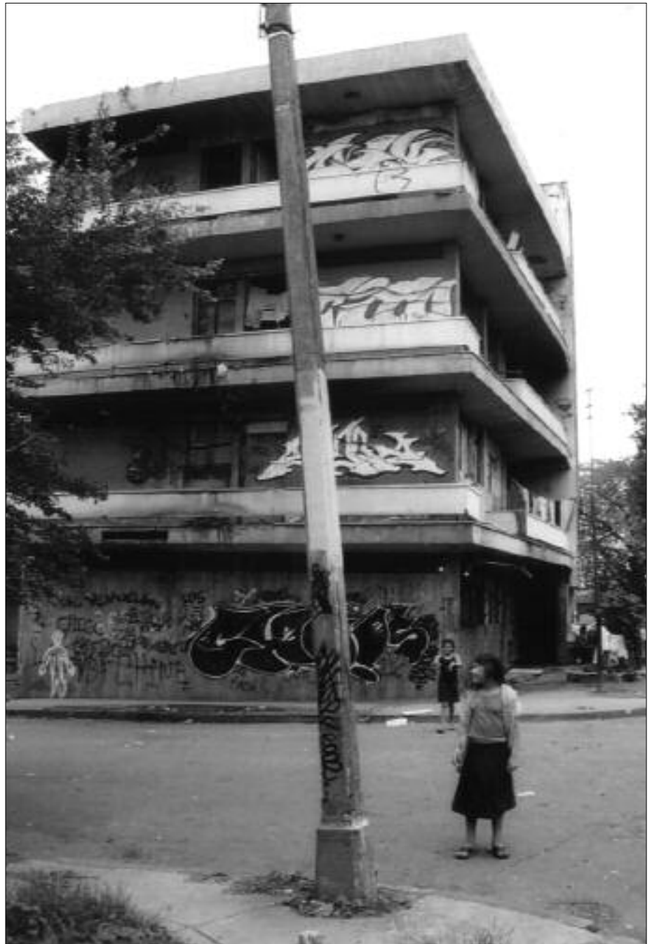
Seit 30 Jahren einsturzgefährdet, Managua
